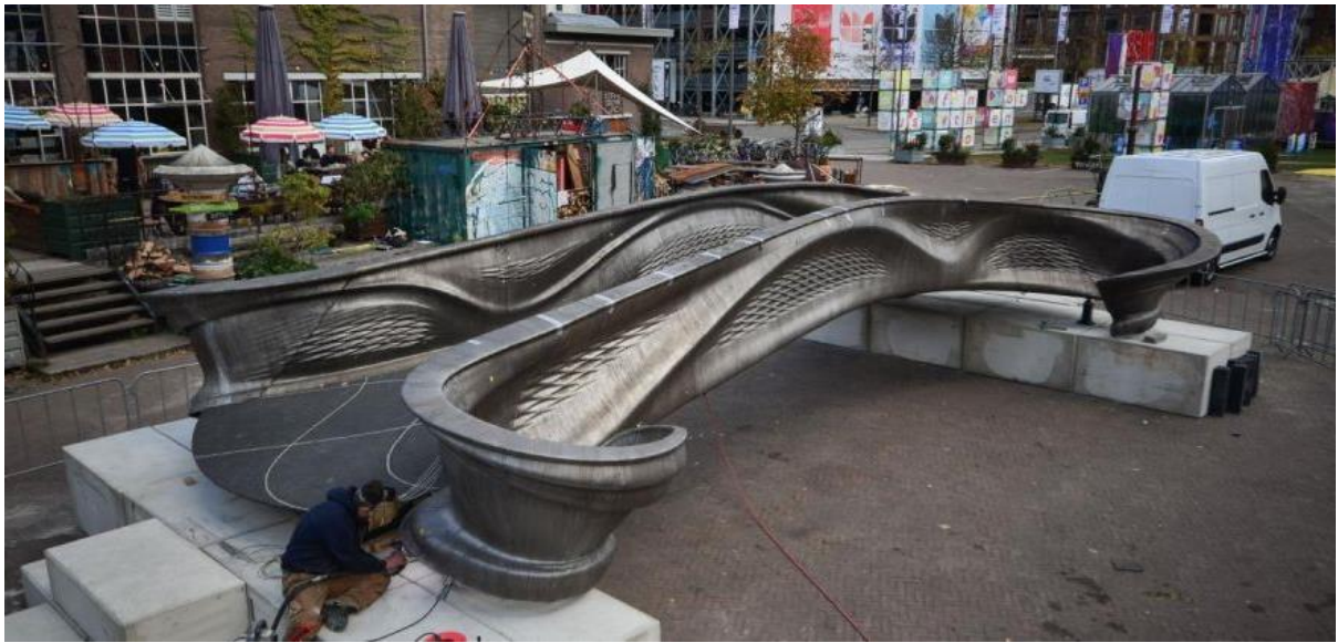
Рисунок 4.11 – Зображення мосту з металу, надрукованого MX3D в Амстердамі
